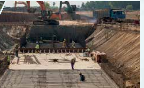
Νέο εργοστάσιο - 2 μονάδες παραγωγής για ογκολογικά φάρμακα στην Τρίπολη
